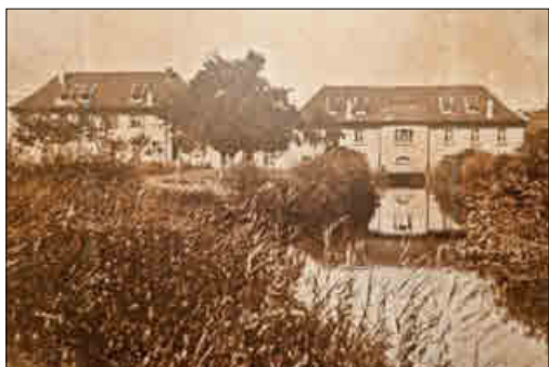
So sah die Umgebung der Gelben Mühle bis 1950 aus, als die Schutter dort noch floss. Erst etwa 1950 wurde sie begradigt und das heutige Bett geschaffen.
