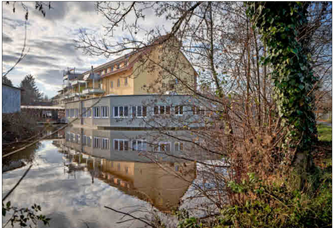
Die Gelbe Mühle an der Schutter in Lahr wurde saniert. Es sind mehrere Wohnungen entstanden.
